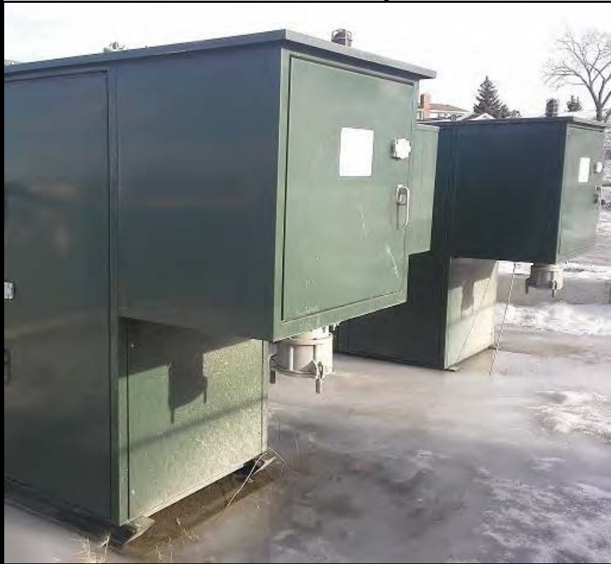
Mostrado arriba: MCS Fabricado 15kV, 600A Acoplador hembra montado en un equipo en servicio
